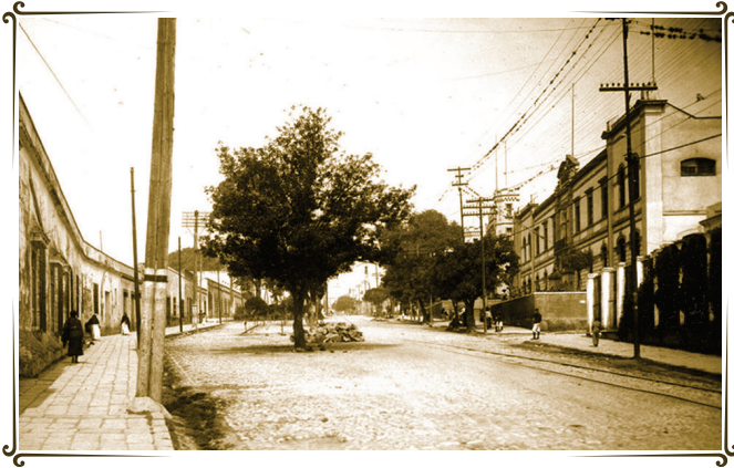
Avenida Observatorio, antes de la vía del tren a Cuernavaca.
