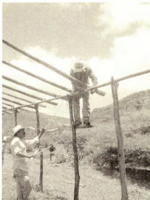
Lámina 9. Construcción en la presa El Bordo
