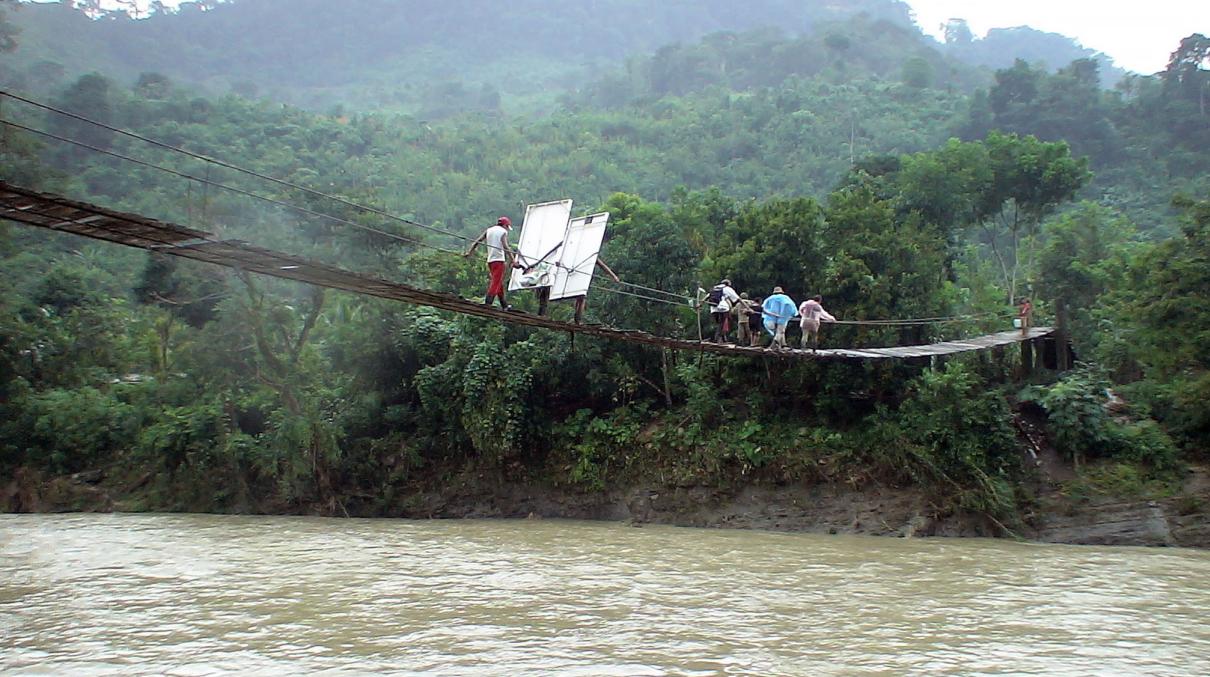
Traslado de paneles solares y baterías para dotar de energía eléctrica y refrigeración a la clínica de salud comunitaria atendida por pasantes.
