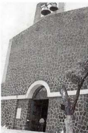
“Fachada principal de la nueva iglesia de Guadalupe”.
