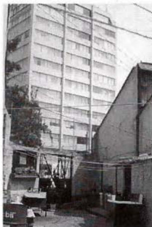
Vista interior de los baños del Deportivo La Hormiga - La Alpina, al fondo Puertas del Pedregal.
