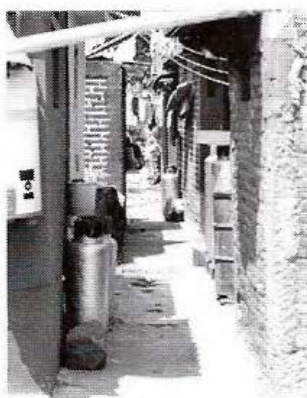
Actualmente pasillo de Canoa 60.
