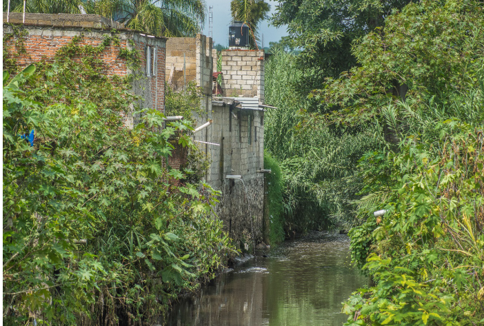
Figura 3.5. Descargas de aguas negras en el sistema hidroagrícola
